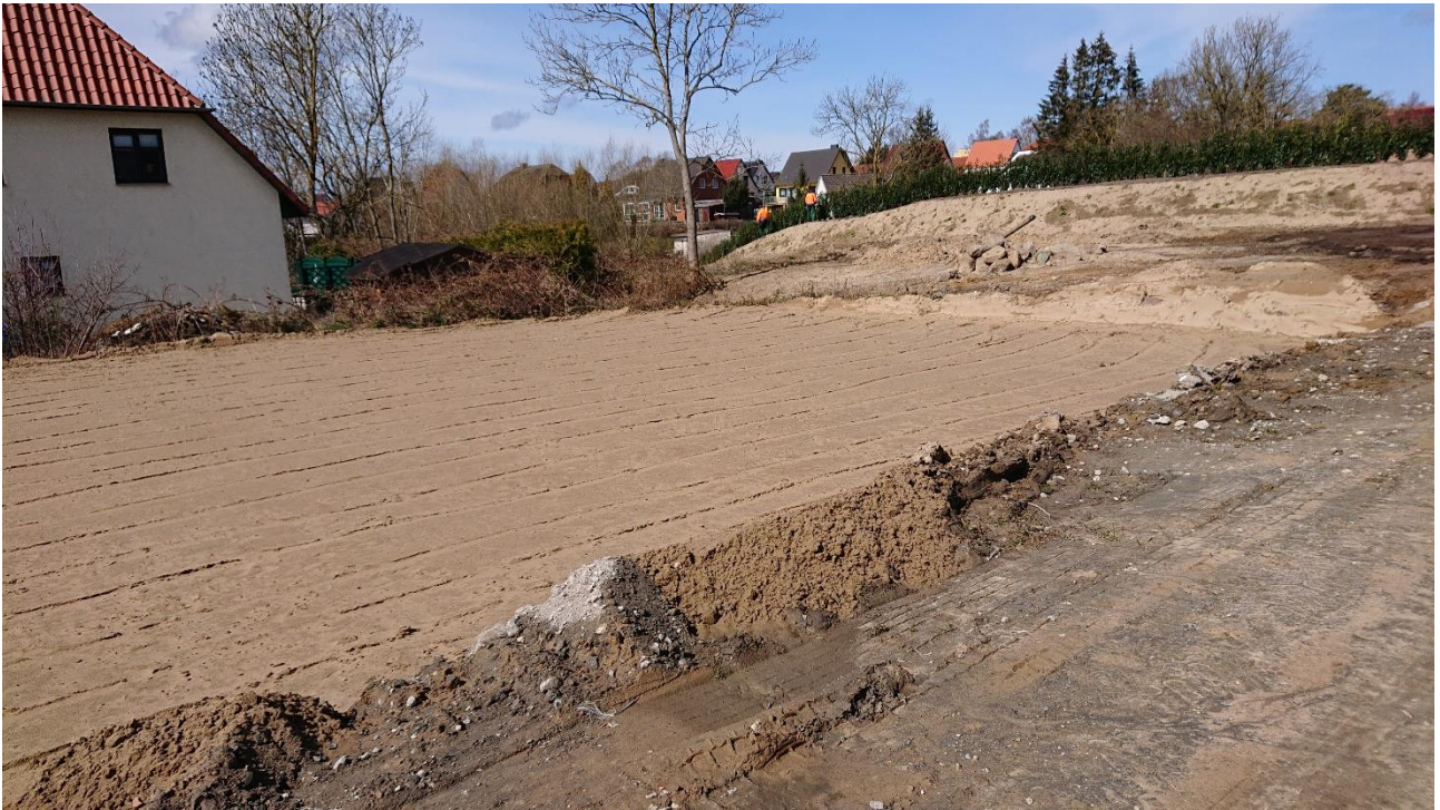
Abbildung 5: Blick auf den mittigen Änderungsbereich, rechts Aufschotterung der Verkehrsfläche
