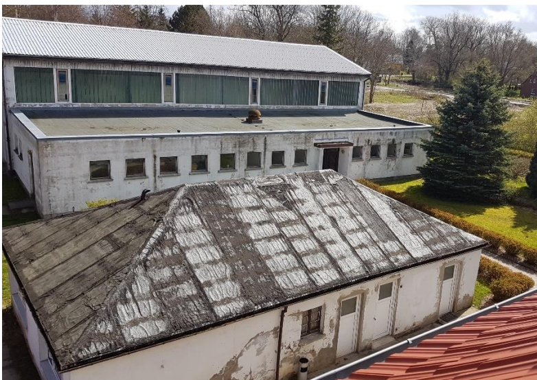
Abb.3: Hintergrund Sporthalle Wiek, Lager/Werkstatt mittig
