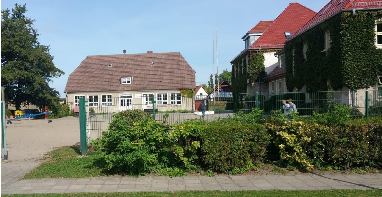
Abb.1: Blick vom Sportplatz zum Schulhof Wiek, rechts Schulgebäude Grundschule, links Hortgebäude Wiek
