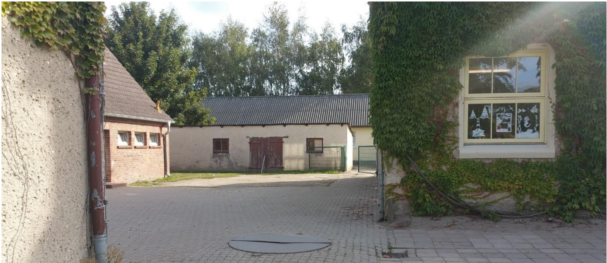
Abb.2: Mitte links WC Gebäude, Mitte Schuppen, rechts Grundschule
