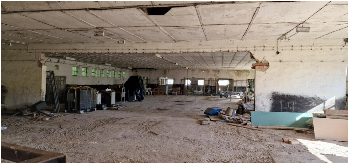
Abbildung 36: Innenbereich von Gebäude 1, südöstlicher Teil.
