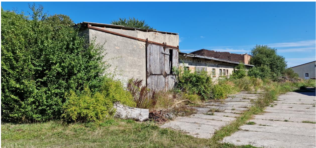
Abbildung 10: Blick aus Nordwesten auf Gebäude 1.
