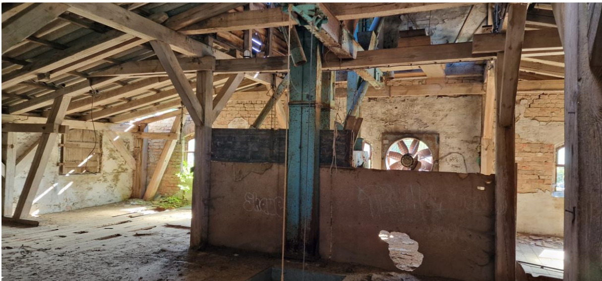
Abbildung 22: Obergeschoss im südlichen Teil von Gebäude 2.
