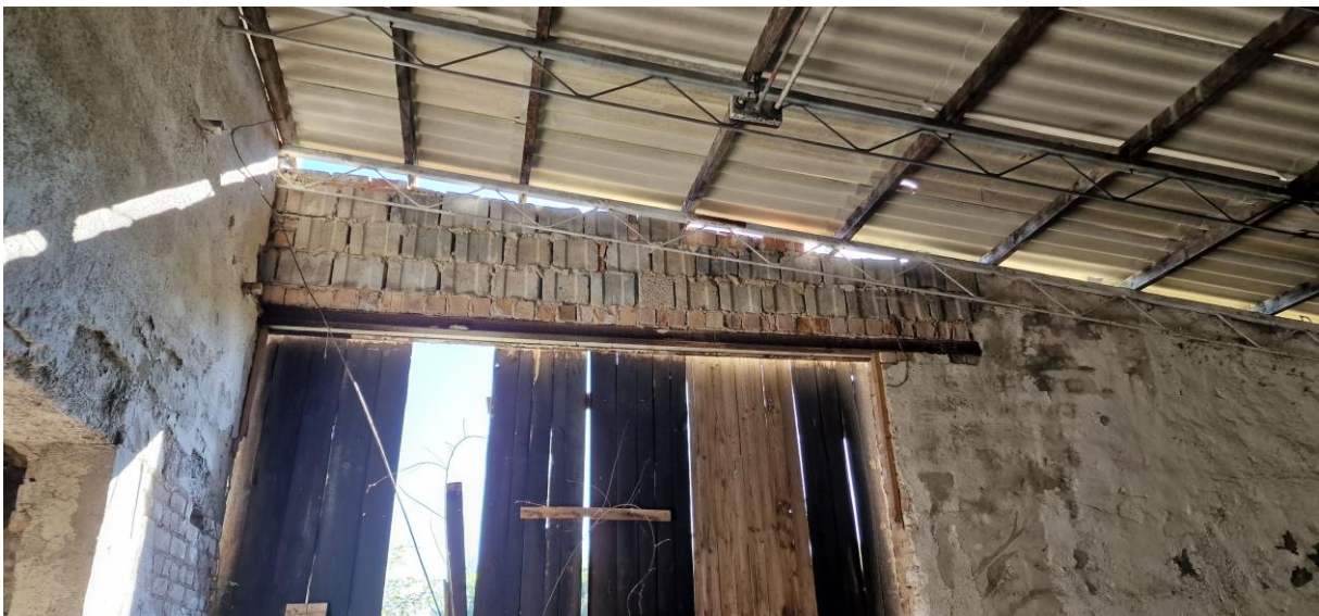
Abbildung 38: Hohlblocksteine mit Quartiermöglichkeiten für Fledermäuse.
