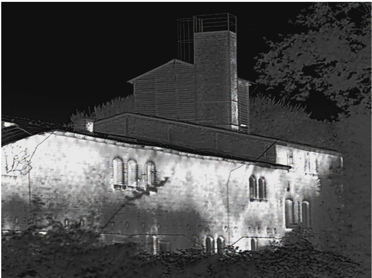
Abbildung 47: Nordwestseite von Gebäude 2 im Wärmebild.
