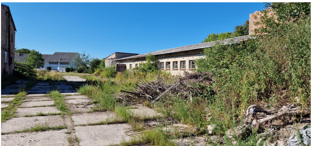
Abbildung 29: Bereich zwischen Gebäude 1 (rechts) und Gebäude 2.
