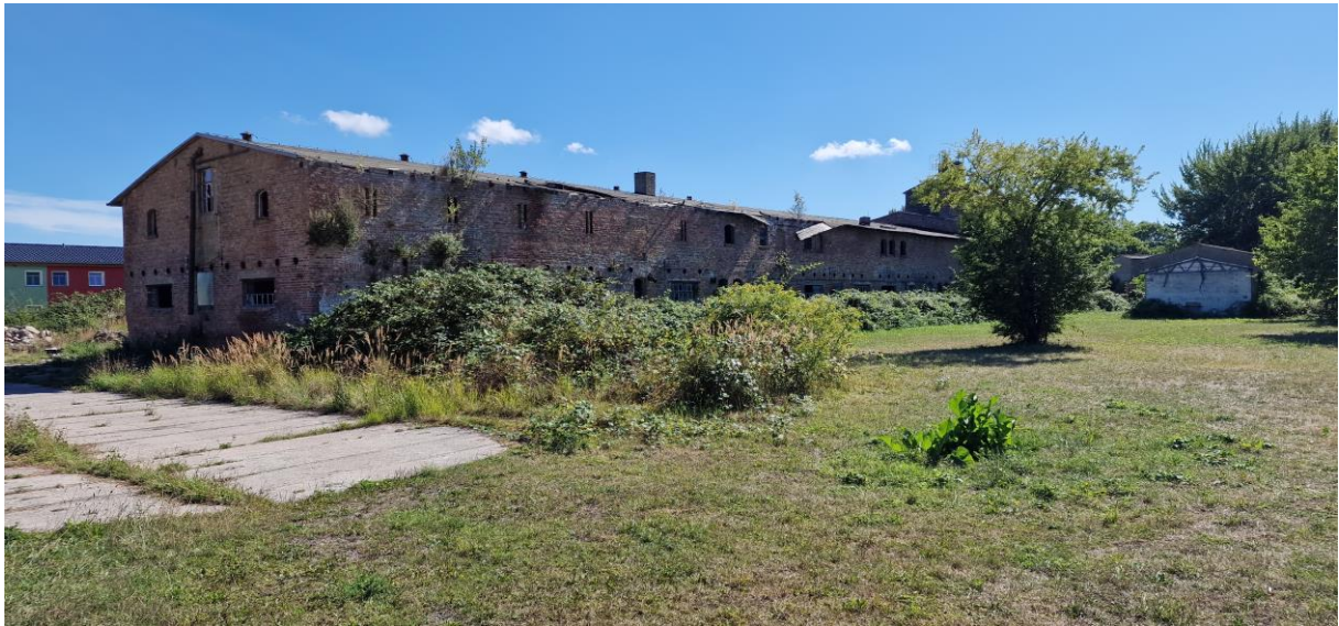
Abbildung 9: Blick aus Norden auf Gebäude 2 und 3.
