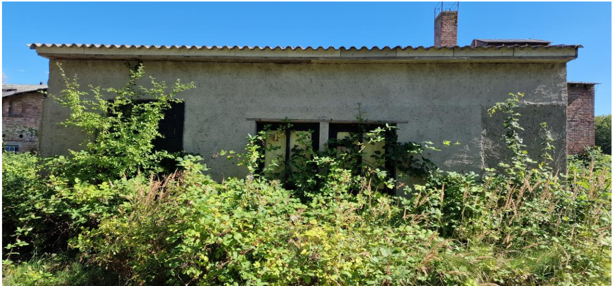
Abbildung 12: Nordwestseite von Gebäude 3.
