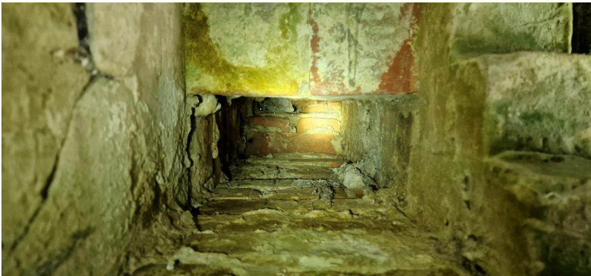
Abbildung 31: Schächte im Innenbereich von Gebäude 2.
