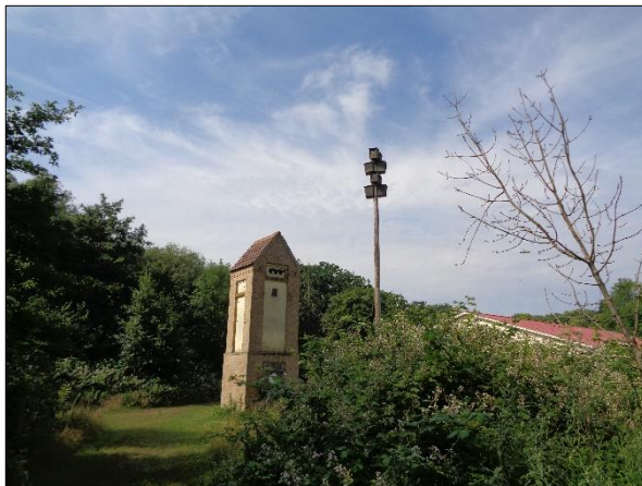
Abb. 19: Altes Trafohäuschen und Vogelnistkästen
