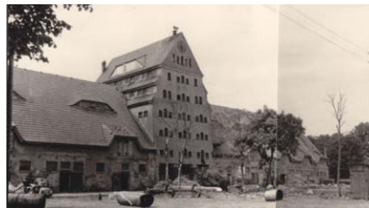
Getreidespeicher mit flankierenden Stallgebäuden, linke Seite bereits zu DDR Zeiten abgerissen und durch flacheren Anbau ersetzt. Foto von 1966
