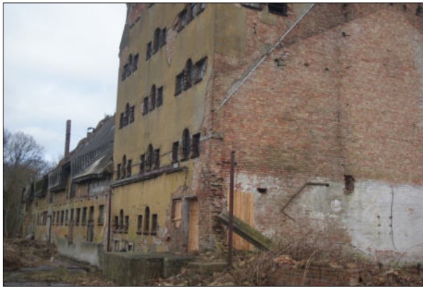
Abb. 9 u. 10: Speicher. Nach Abbruch des südlichen Stalltraktes freiliegendes, unverputztes, ehemals als Innenwand erstelltes und nun als Außenmauerwerk fungierendes Südgiebel-Mauerwerk. Das Mauerwerk weist eine Vielzahl von Nischen wie z.B. ehem. Balkenlöcher auf (Pfeile). BEACHTEN: Der Abbruch des südlichen Stallteiles erfolgte bereits vor Jahren.
