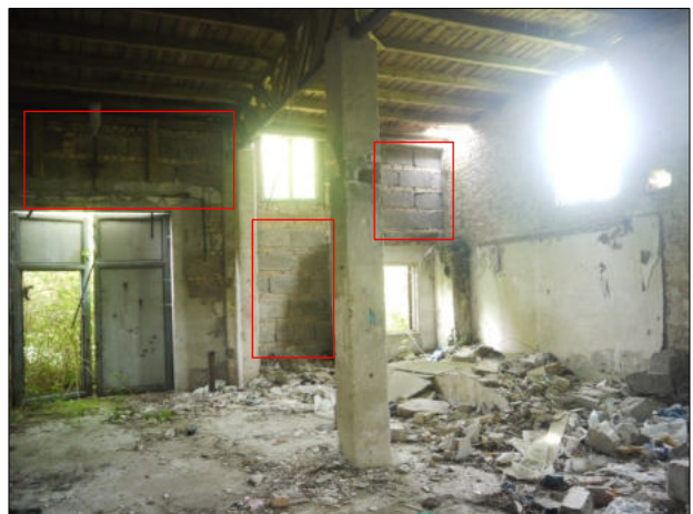
Abb. 25 u. 26: Außen- und Innenansicht des nordöstlichen Gebäudeteiles vom Werkstatt-Gebäude (Gebäude C) mit hohem, hallenartigem Raum. Zu beachten ist hier das großflächig vorhandene unverputzte Mauerwerk aus Hohlblocksteinen (siehe Rechtecke) mit einer Vielzahl von Schadstellen an den verbauten Steinen selbst sowie einer Vielzahl offener, tiefer Mauerwerkfugen.
