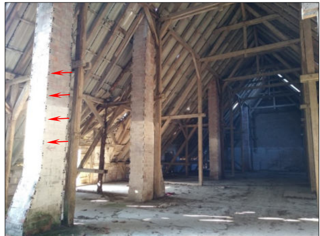
Abb. 6: Ansicht Dachgeschoss Stalltrakt mit Lüftungszügen aus Langlochziegel mit offener (unverputzter) Stirnseite (Pfeile).
