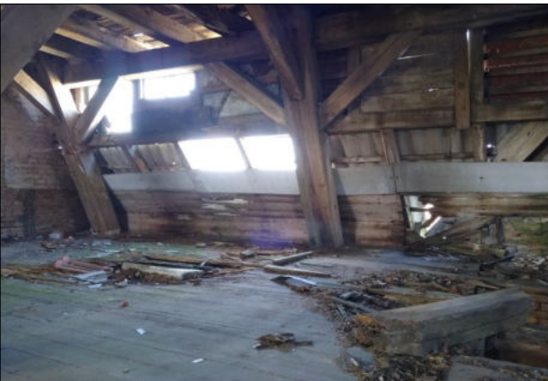
Abb. 11 - 14: Speicher. Innenansicht verschiedener Geschosse. Der Zustand von Dacheindeckung und Zwischenböden ist z.T. ruinös. Die Räume sind allesamt stark bewettert. Für z.B. Fledermäuse potentiell als Quartier nutzbare Zapfenlöcher und Balkenkehlen sind in der Holzständerkonstruktion nicht vorhanden.
