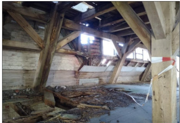
Abb. 11 - 14: Speicher. Innenansicht verschiedener Geschosse. Der Zustand von Dacheindeckung und Zwischenböden ist z.T. ruinös. Die Räume sind allesamt stark bewettert. Für z.B. Fledermäuse potentiell als Quartier nutzbare Zapfenlöcher und Balkenkehlen sind in der Holzständerkonstruktion nicht vorhanden.
