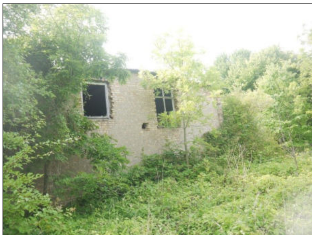
Abb. 25 u. 26: Außen- und Innenansicht des nordöstlichen Gebäudeteiles vom Werkstatt-Gebäude (Gebäude C) mit hohem, hallenartigem Raum. Zu beachten ist hier das großflächig vorhandene unverputzte Mauerwerk aus Hohlblocksteinen (siehe Rechtecke) mit einer Vielzahl von Schadstellen an den verbauten Steinen selbst sowie einer Vielzahl offener, tiefer Mauerwerkfugen.
