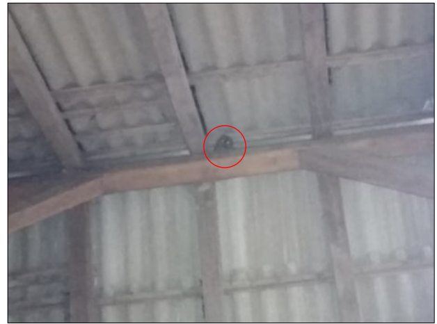
Abb. 69: Waldkauz (Kreis) im Tageseinstand im Dachstuhl des Stalltraktes vom Stallspeicher.
