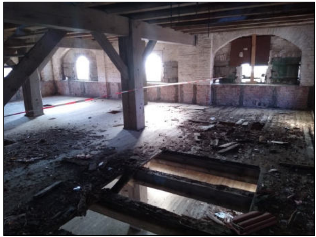
Abb. 9 u. 10: Speicher. Nach Abbruch des südlichen Stalltraktes freiliegendes, unverputztes, ehemals als Innenwand erstelltes und nun als Außenmauerwerk fungierendes Südgiebel-Mauerwerk. Das Mauerwerk weist eine Vielzahl von Nischen wie z.B. ehem. Balkenlöcher auf (Pfeile). BEACHTEN: Der Abbruch des südlichen Stallteiles erfolgte bereits vor Jahren.
