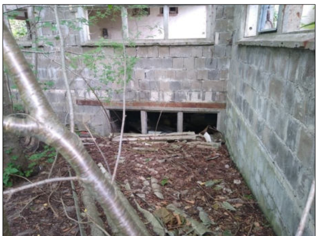
Abb. 58 u. 59: Unverputzte Außenwandbereiche am nordwestlichen (unterkellerten) Gebäudeteil mit einigen offenen Stoßfugen (siehe Pfeile).
