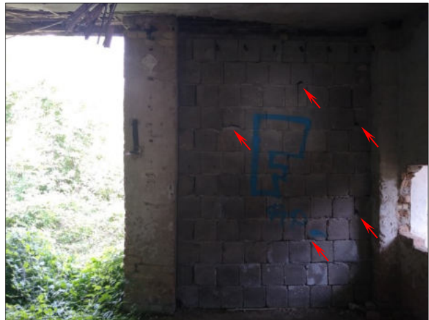
Abb. 36 u. 37: Außen- und Innenansicht des Garagentraktes von Gebäude C. Auch das Mauerwerk dieser Garagen wurde z.T. aus Beton-Hohlblocksteinen erbaut. Auf der Rauminnenseite ist dieses Mauerwerk weitestgehend unverputzt und weist eine Vielzahl an für Fledermäuse nutzbaren Spaltenstrukturen und Hohlräume (Pfeile) auf.
