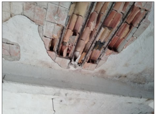
Abb. 7 u. 8: Stalltrakt. Teilansicht des Erdgeschosses mit zahlreichen Schadstellen (Pfeile) in der Hohlziegeldecke.
