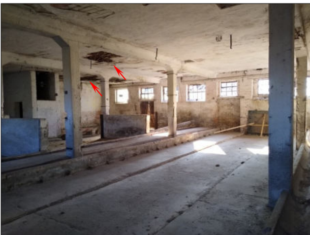
Abb. 7 u. 8: Stalltrakt. Teilansicht des Erdgeschosses mit zahlreichen Schadstellen (Pfeile) in der Hohlziegeldecke.
