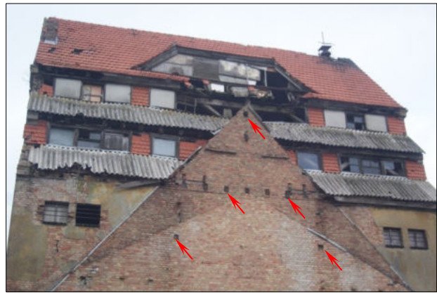
Abb. 9 u. 10: Speicher. Nach Abbruch des südlichen Stalltraktes freiliegendes, unverputztes, ehemals als Innenwand erstelltes und nun als Außenmauerwerk fungierendes Südgiebel-Mauerwerk. Das Mauerwerk weist eine Vielzahl von Nischen wie z.B. ehem. Balkenlöcher auf (Pfeile). BEACHTEN: Der Abbruch des südlichen Stallteiles erfolgte bereits vor Jahren.
