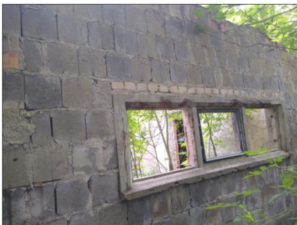
Abb. 58 u. 59: Unverputzte Außenwandbereiche am nordwestlichen (unterkellerten) Gebäudeteil mit einigen offenen Stoßfugen (siehe Pfeile).
