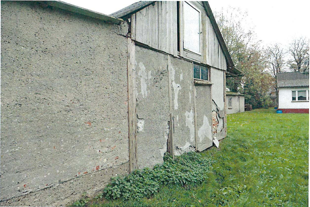
**Abbildung 3: Blick auf die schadhafte Giebelwand am Stallgebäude. Durch die Lücke in der Verschalung neben dem Fenster können Tiere das Gebäude besiedeln.**
